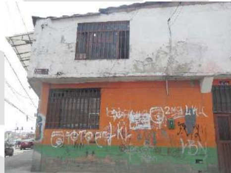
C1. Fachada Calle 6
