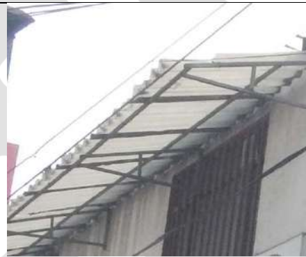
M1. Cubierta exterior
