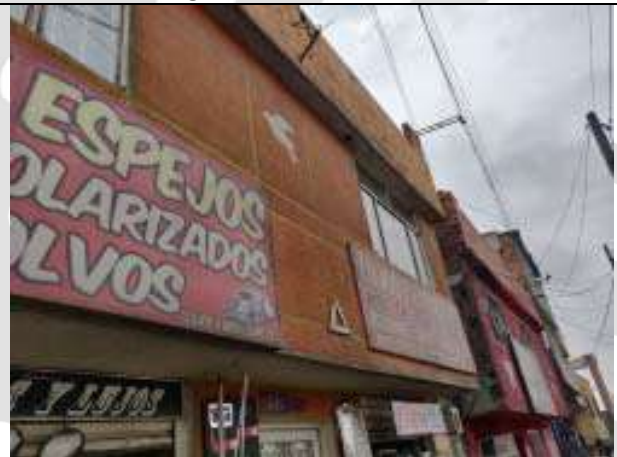
Voladizos sobre fachada – piso 1
