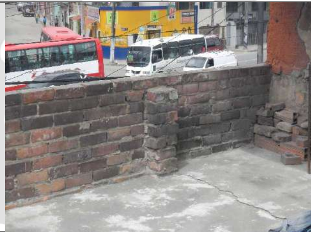
M3: Antepecho en ladrillo
