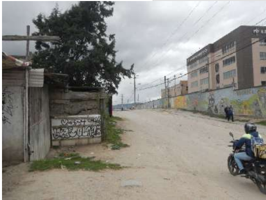
Vista general carrera transversa 5ª
