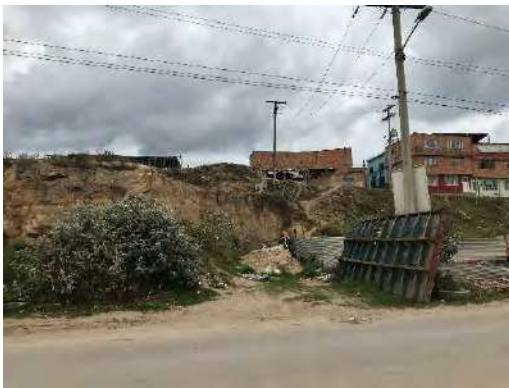
Fachada Calle 7ª
