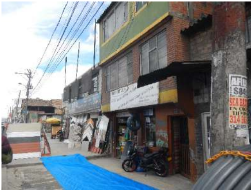
Vista general Carrera 4 (Autopista Sur).
