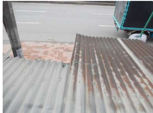
M1: Cubierta exterior.
