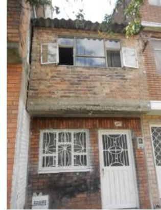
Fachada Carrera 5 (Corredor Férreo).
