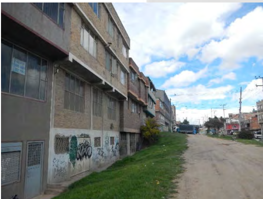
Vista general Carrera 5 (Corredor Férreo).
