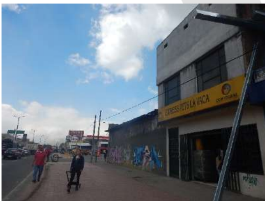
Fachada Carrera 4 (Autopista Sur) 257540101000001070008000000000. C2: FACHADA
