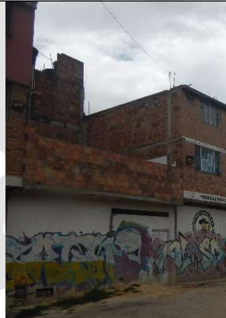
Vista general Carrera 5 (Corredor Férreo) 257540101000001070015000000000. C3: FACHADA POSTERIOR
