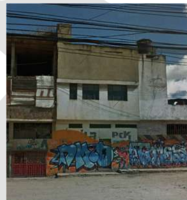
Vista general Carrera 4 (Autopista Sur) 257540101000001070008000000000. C2: FACHADA POSTERIOR
