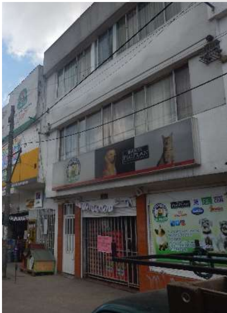
Fachada Carrera 4 (Autopista Sur) 257540101000001070015000000000. C3: FACHADA
