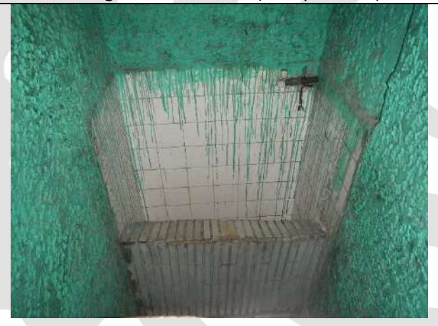
Baño (orinal) Local – Piso 1
