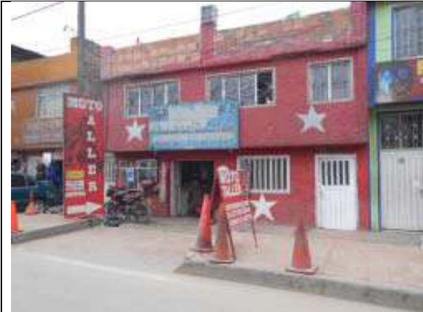
Fachada principal – Carrera 4 (Autopista sur)
