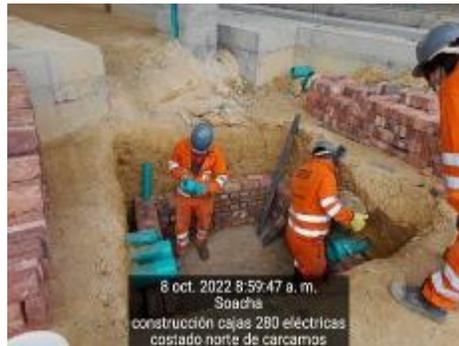
Construcción de caja CS280 costado norte de cárcamos.
