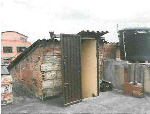
M6: Muro Bloque Punto Fijo.
