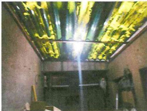
Deposito (Patio Cubierto) Piso 1.
