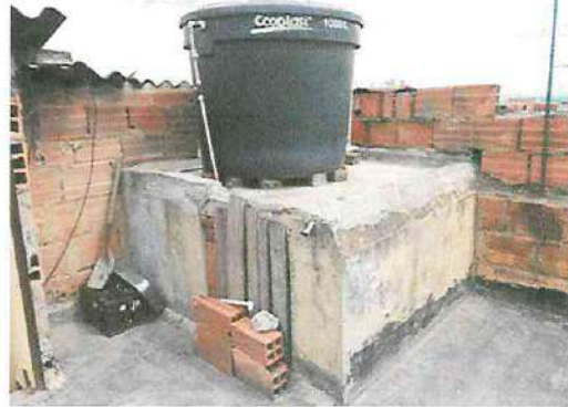
Cuarto Deposito En Terraza.
