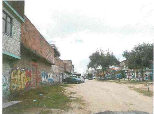
Vista general Carrera 5 (Corredor Férreo).
