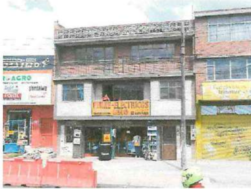
Fachada Carrera 4 (Autopista Sur).
