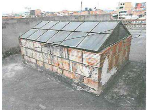
M7: Cubierta Vidrio
