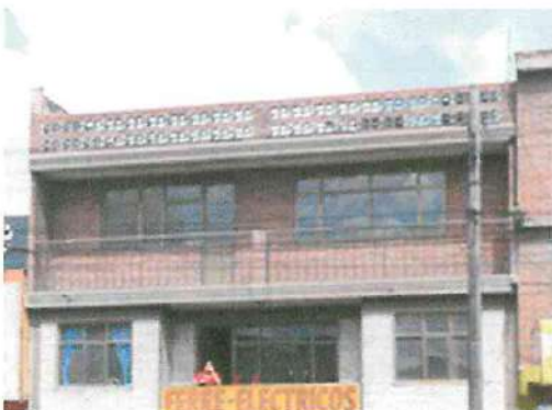
M10: Placa Volada Concreto fachada frontal.
