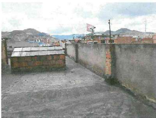
M4: Muros Laterales
