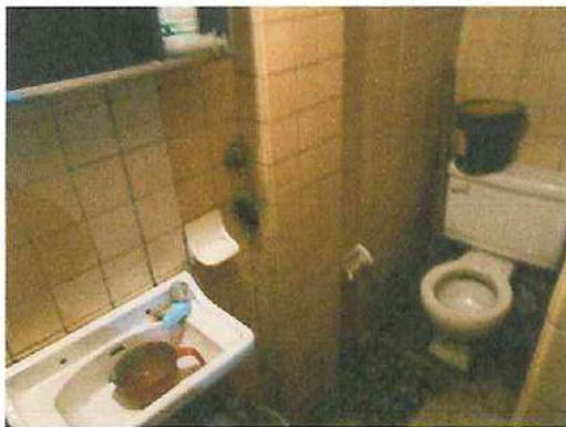
Baño #1 Bajo Escalera Piso 1.
