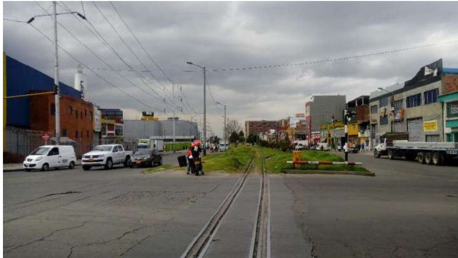
Fotografía 1 Primer Tramo del Corredor Principal Av. Ferrocarril por Carrera 22
