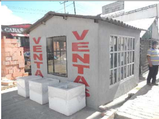
C1. Construcción un piso
