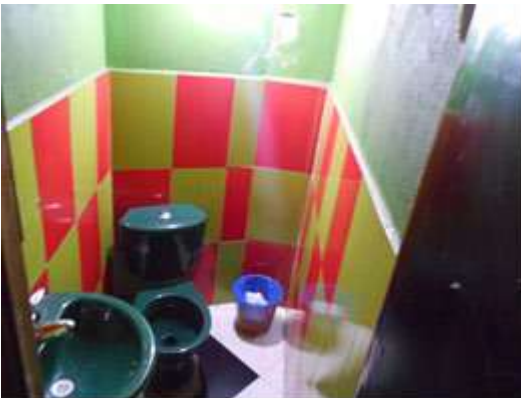
C3: Baño #1 Local Comercial Piso 1.
