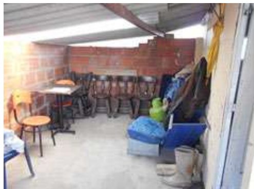
M12 Muros Perimetrales En Segundo Nivel
