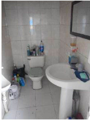
C1: Baño #2 Local Comercial Piso 1.
