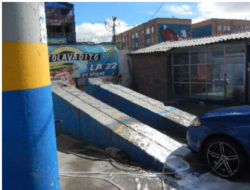
M2 Rampas En Mampostería Y Concreto
