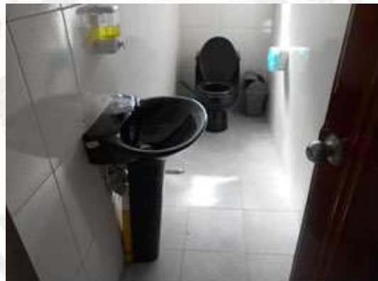
C1: Baño #1 Local Comercial Piso 1.
