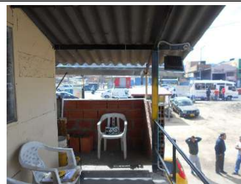
M11 Enramada Cubierta De Placa En Segundo Nivel
