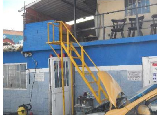
M9 Escalera Metálica De Acceso Segundo Nivel
