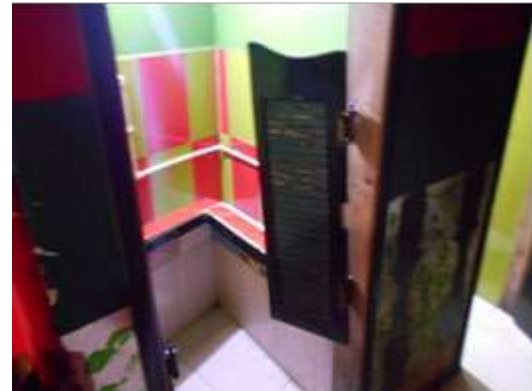
C3: Cuarto de orinal #2 Local Comercial Piso 1.
