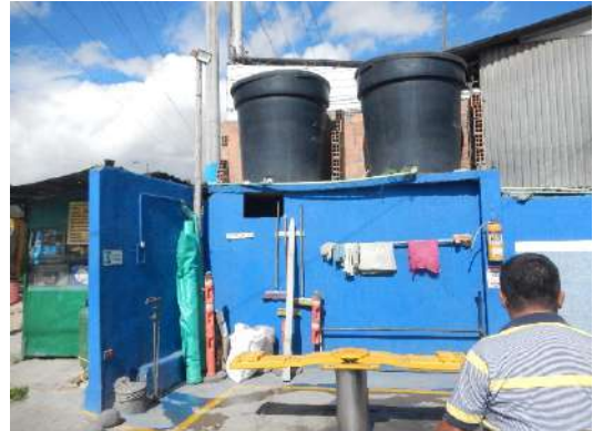
C4. M5 Tanques (PVC)
