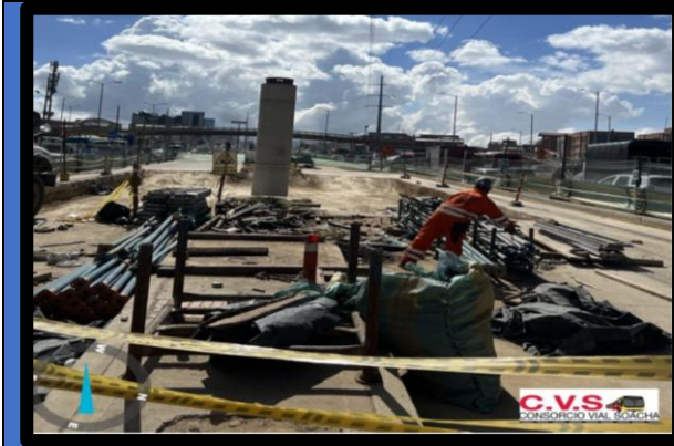
Puente Vehicular Calle 22
